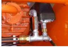
Abb. 89: Druckschalter Luftkompressor
